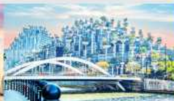
อาคารฟันทันไม้
